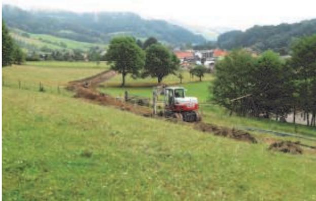
Vor kurzem wurde mit der Quelfassung und Leitungsverlegung einer neuen Quelle begonnen. Das Wasser wurde bereits freigelegt und die Leitung zum Anschluss an das bestehende Netz verlegt. Es fehlt jetzt noch der Quellsammelschacht sowie ein Wartungsgebäude neben der Gemeinde, in dem eine Druckverstärkerpumpe und eine Desinfektionsanlage eingebaut werden. Letztere ist nicht auf Grund schlechter Wasserqualität von Nöten sondern wegen be-
