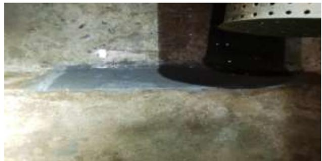
Bei einer Kleinflächensanierung werden Schadstellen im Beton mittels Spezialmörtel glatt verspachtelt. Dieser verbindet sich dann mit dem bestehenden Beton, sodass die Dichtheit wieder gewährleistet ist.
